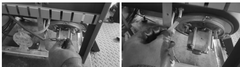
a) Cabos de ligação
